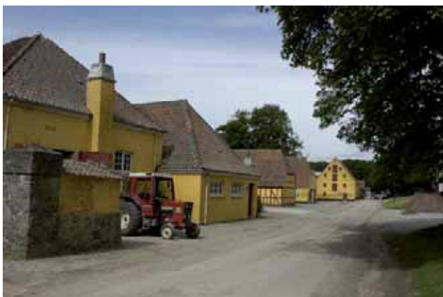
De gulkalkede avlsbygninger med smedjen i forgrunden
